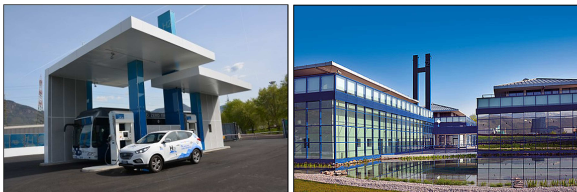
Figura 8: La stazione idrogeno di Bolzano
